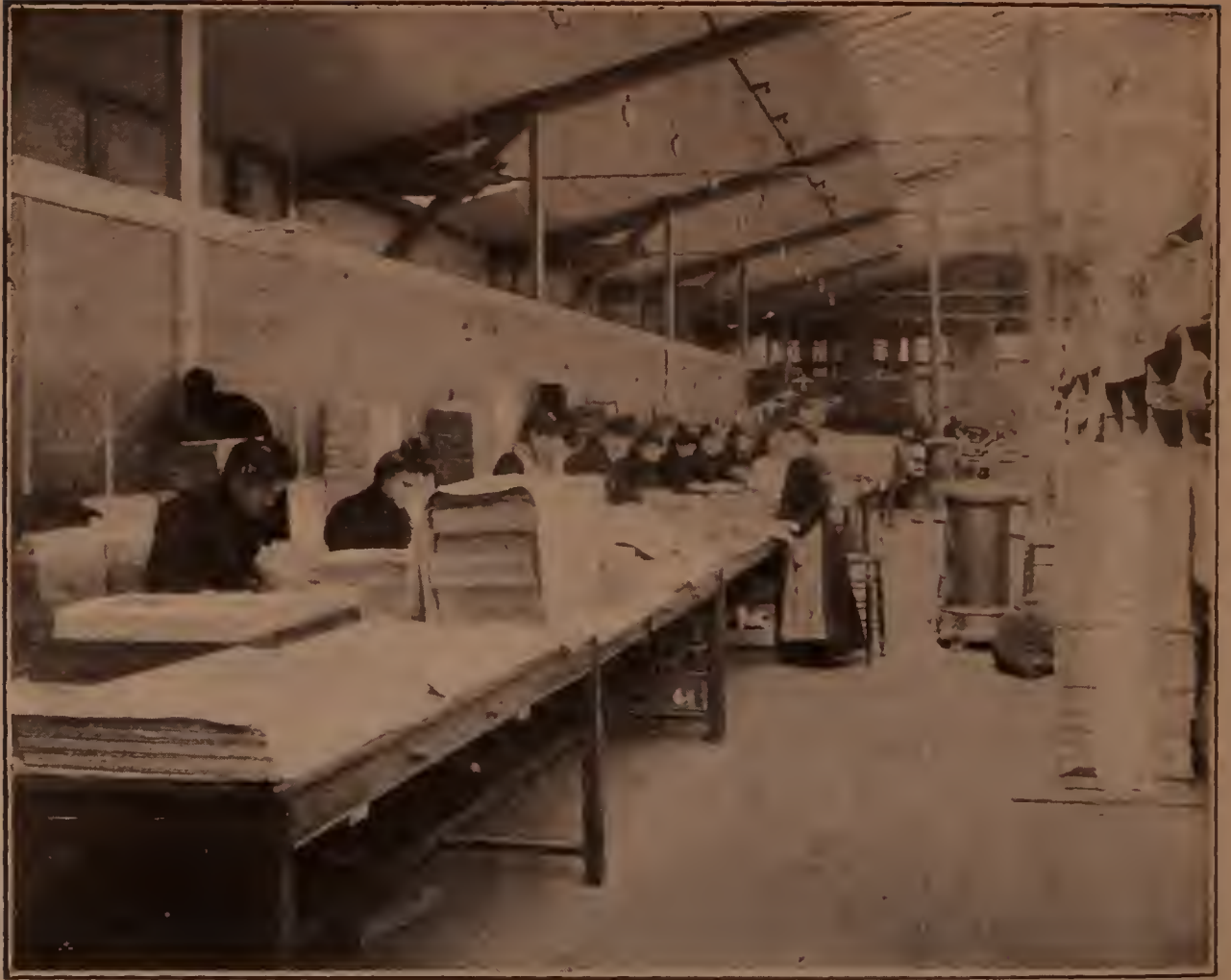
Salle de nettoyage des épreuves.
